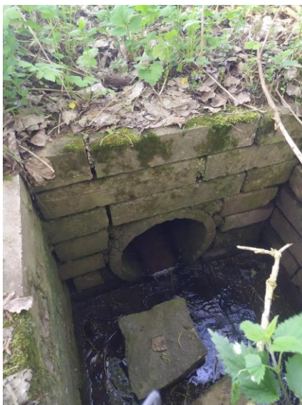
Obr. 43: Vyústění meliorace v lokalitě Pomeznice (Zdroj: Archiv ŽV, 2023)
